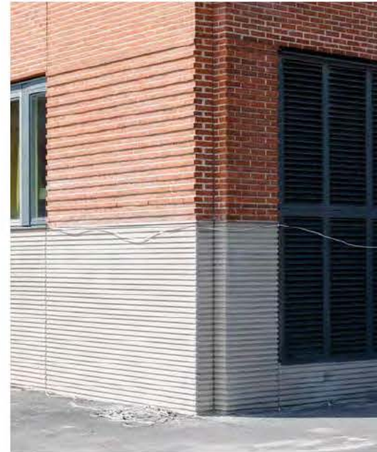
← Campus USÖ, exteriör Hörn, betongsockel och tegel
