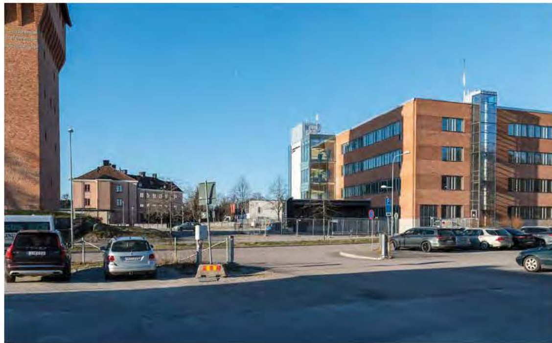
Campus USÖ, exteriör Vy mot söder. Mellanrum <
