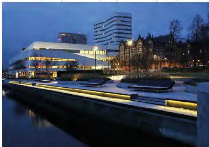
Gradängernas trappnosar är försedda med integrerade linjära armaturer
