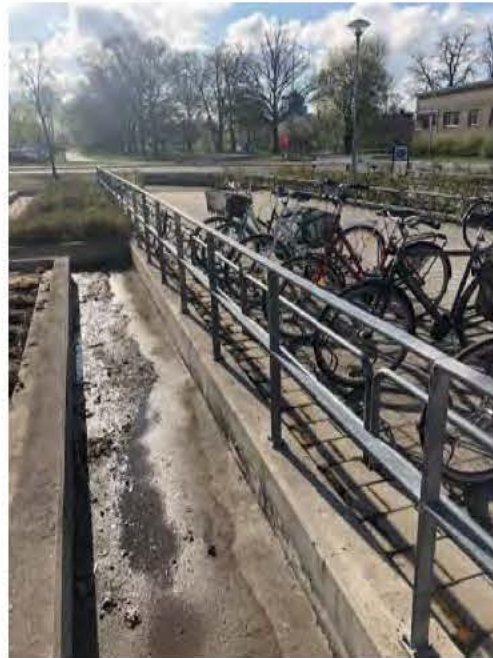
Gjuten räna för Lokalt omhändertagande av dagvatten. >
