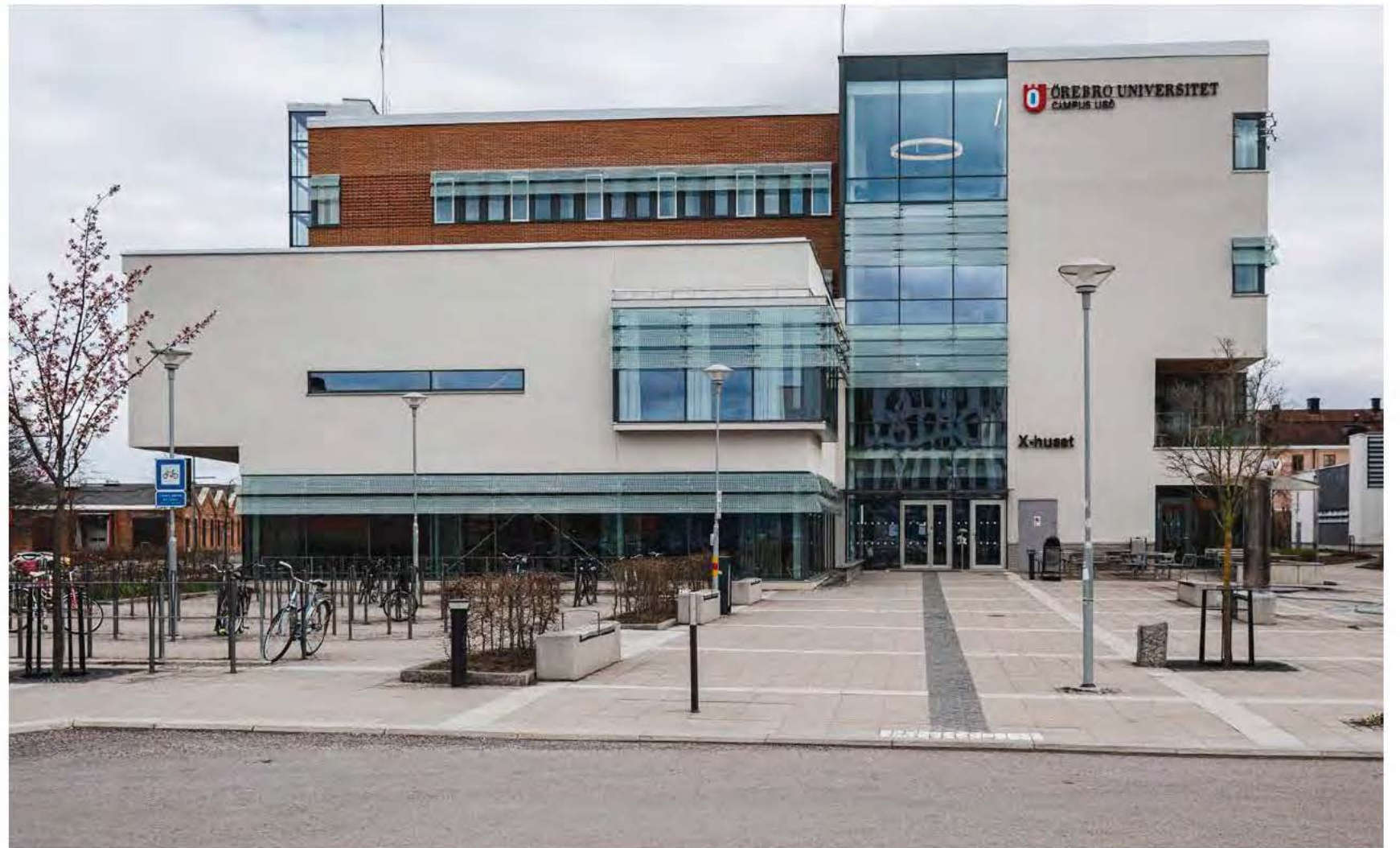
Campus USÖ, exteriör
