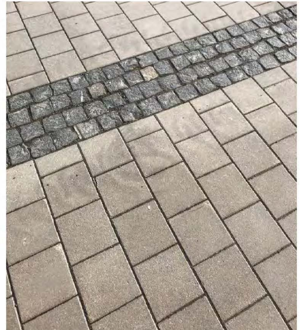
< Östra entrén med betongplattor och smågatsten.
