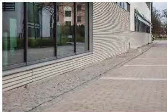
Campus USÖ, exteriör Sockel i betong. Möte med mark
