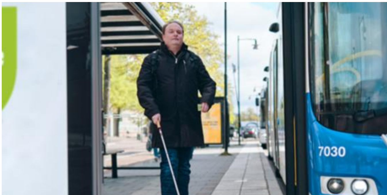
Figur 48 Taktila plattor, kontrastmarkering och kantstenshöjd på 17 cm krävs för att en hållplats ska kategoriseras som fullt ut tillgänglighetsanpassad (Foto VL).
