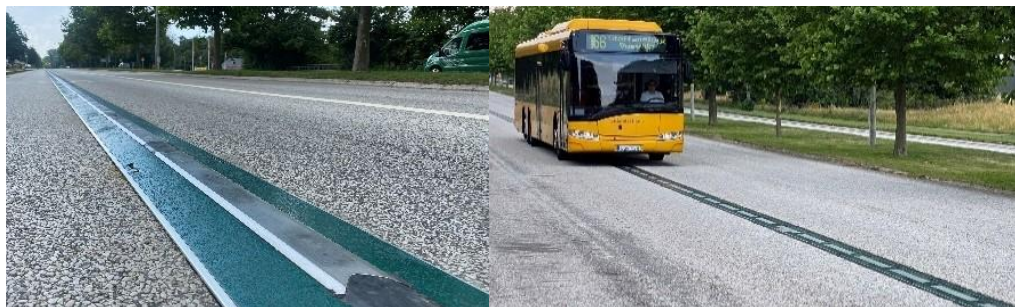
Figur 3.9 Elonroads upphöjda respektive nedsänkta skena
