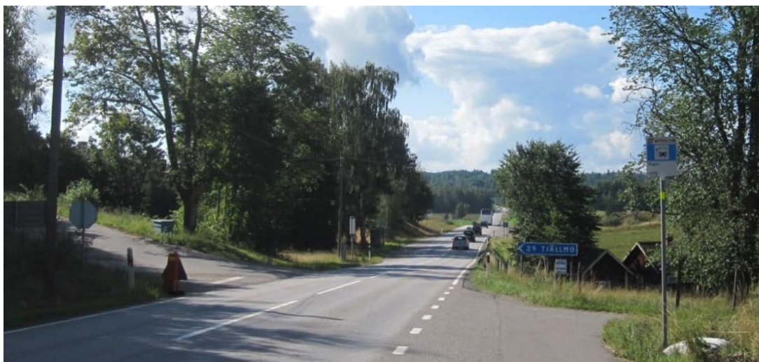
Bild 2. Väg 50 på norra delen av sträckan, vy söderut från Dalhem. Här byggs vägen i nysträckning väster om befintlig väg.
